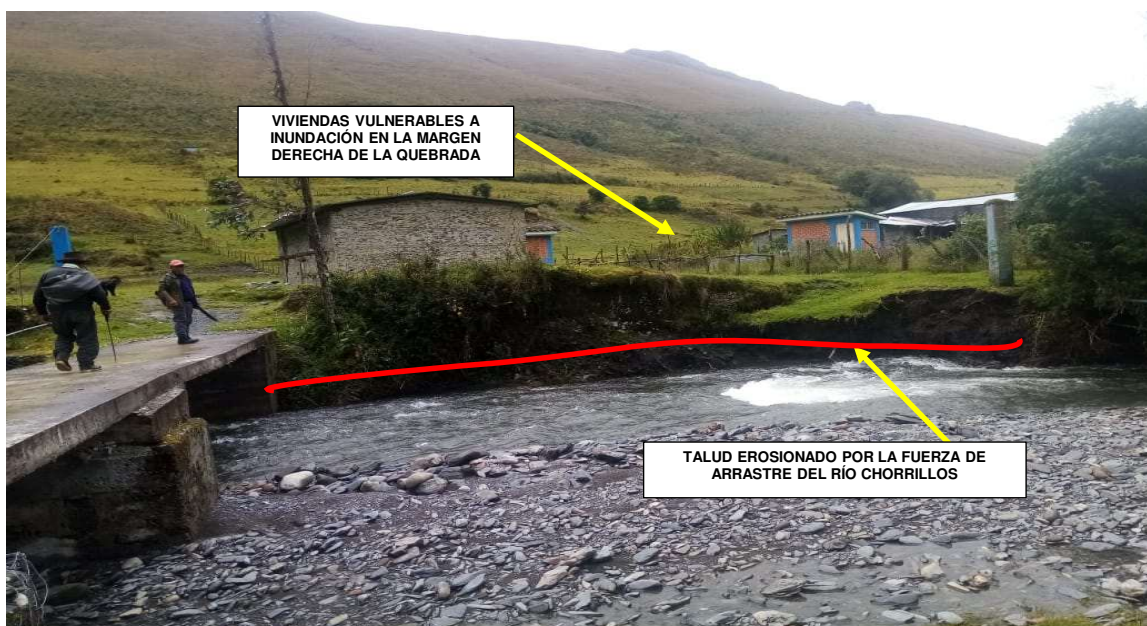
FIGURA N°02: VISTA DE EROSIÓN DE TALUD DE LA MARGEN DERECHA POR EFECTOS DE FUERZA DE ARRASTRE DE LA QUEBRADA RANGRACANCA. VIVIENDAS VULNERABLES A INUNDACIÓN EN LA MARGEN DERECHA DEL RÍO CHORRILLOS
