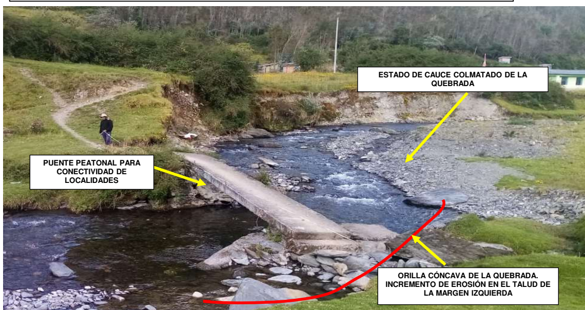
FIGURA N°03: VISTA DE AFECTACIÓN DE BASE DEL PUENTE PEATONAL POR EFECTOS DE EROSIÓN Y SOCAVACIÓN EN LA MARGEN IZQUIERDA DE LA QUEBRADA RANGRACANCA. DICHO PUENTE SIRVE PARA LA CONECTIVIDAD DE LOCALIDADES EN EL CENTRO POBLADO ANCHIHUAY SIERRA
